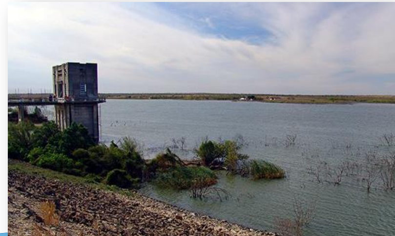
Obra de toma Presa Marte R. Gómez (El Azúcar).
